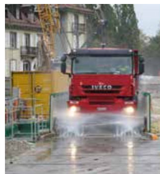
Chantier CIO, Lavage des camions
