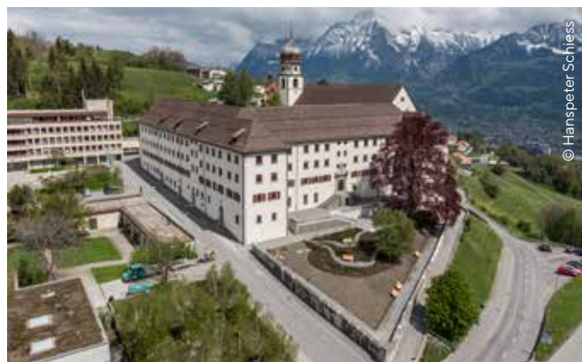
Sanierung Klostergebäude Klinik Pfäfers.
