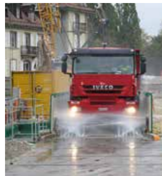
Chantier CIO, Lavage des camions
